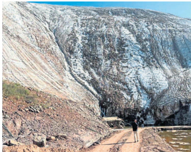
Una imagen de la escombrera, con zanja y balsa de captación
